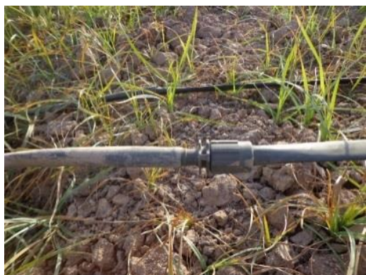
شکل ۴- لوله ۱۶ میلی‌متر و رابط برای اتصال نوار تیپ به لوله مانیفولد زیر خاک
