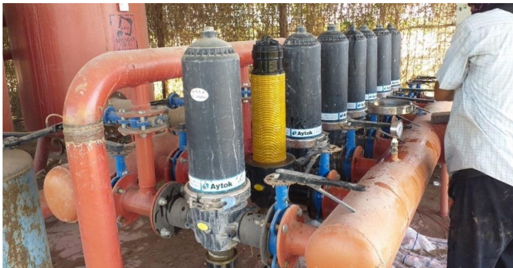
شکل ۱۹- استفاده از فیلترهای نامناسب موجب گرفتگی لوله‌های تیپ خواهد شد
