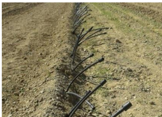
شکل ۴- لوله ۱۶ میلی‌متر و رابط برای اتصال نوار تیپ به لوله مانیفولد زیر خاک
