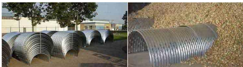
شکل ۱۷- تهویه از کف با کانال‌های فلزی قابل حمل (بالا). جمع‌آوری کانال‌ها بعد از تخلیه پیاز از انبارها (پایین)
