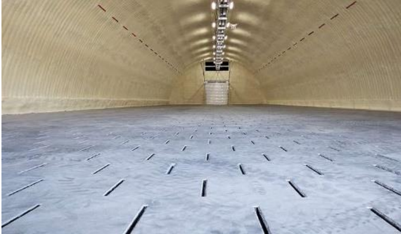
شکل ۱۳- شکاف‌های کف انبار برای گردش هوا
