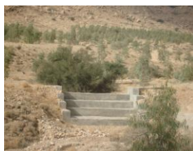
شکل ۱۴- پروژه آبخیزداری نهال کاری همراه با بند رسوبگیرسنگی ملاتی شهرستان بهمنی
