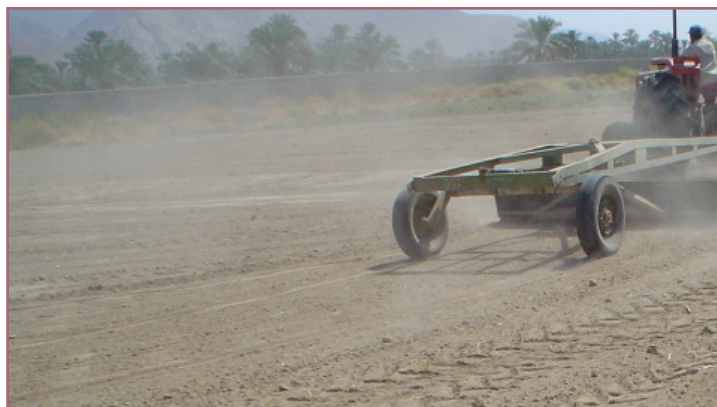
شکل ۲- عملیات تسطیح زمین
