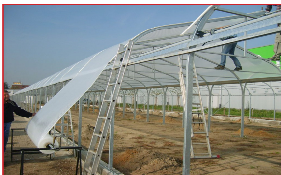
شکل ۱- نصب پلاستیک بر روی گلخانه
