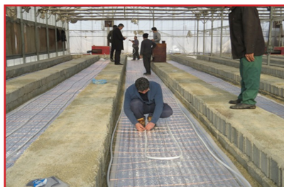
شکل ۸- سیستم‌های گرمایش از کف گلخانه
