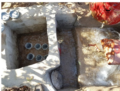
شکل ۸- وضعیت نصب و استقرار لوله‌های زیرسطحی پی‌وی‌سی در کنار درختان پسته (شکل الف) و در ردیف‌ها (شکل ب).
