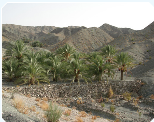
شکل ۶- سازه سنتی درِ بند با احداث دیواره سنگی خشکه‌چین به ارتفاع بیش از ۵ متر در عرض دره نسبتاً عمیق و نخل کاری در آن
