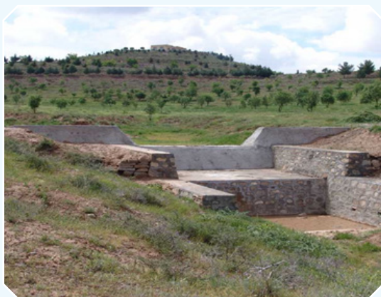
شکل ۵- اجرای عملیات مکانیکی و بیولوژیکی در حوزه‌های آبخیز (احداث سازه سنگی ملاتی و نهال کاری)
