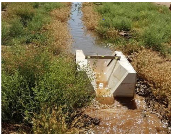
شکل ۸- WSC فلوم تیپ ۴ نصب شده در کانال اصلی ورودی
