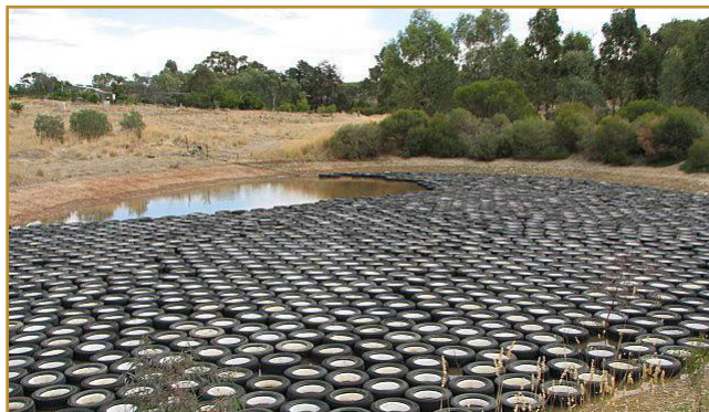
شکل ۸- نمونه‌ای از پوشش یونورینگ (تایر فرسوده شناور)
