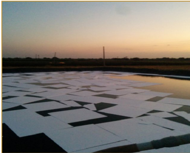
شکل ۶- نمونه‌ای از کاربرد پوشش یونولیت در استخر ذخیره آب کشاورزی
