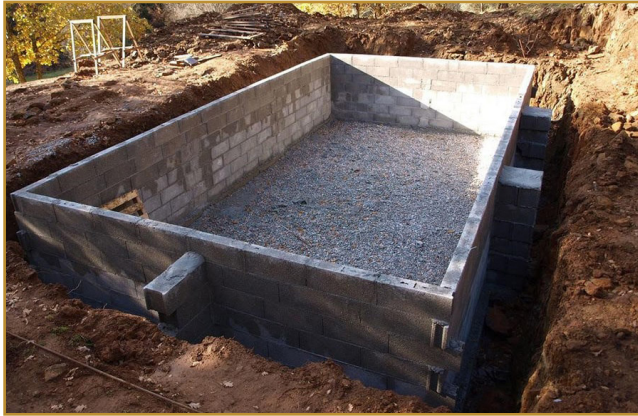
شکل ۱- نمونه‌ای از احداث استخر ذخیره آب کشاورزی با مصالح بلوک سیمانی
