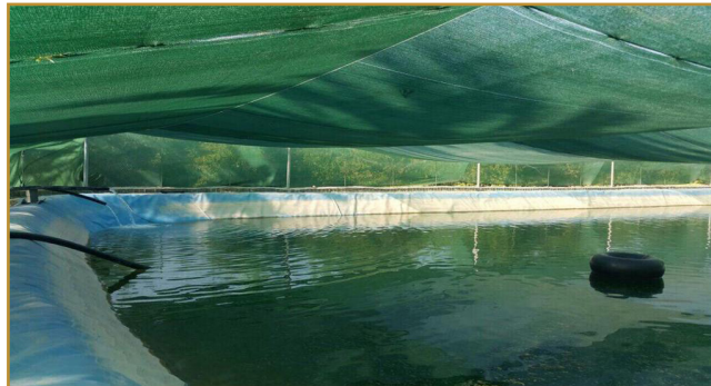
شکل ۴- نمونه‌ای از کاربرد توری سایبان در پوشش سطح استخر ذخیره آب کشاورزی
