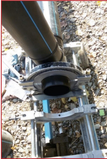
شکل ۵- جوشکاری اتصالات پلی اتیلنی
