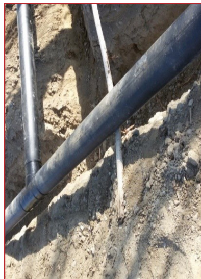
شکل ۶ - آماده کردن لوله های شبکه توزیع به همراه جوش اتصالات و همچنین کنترل عمق ترانشه قبل
