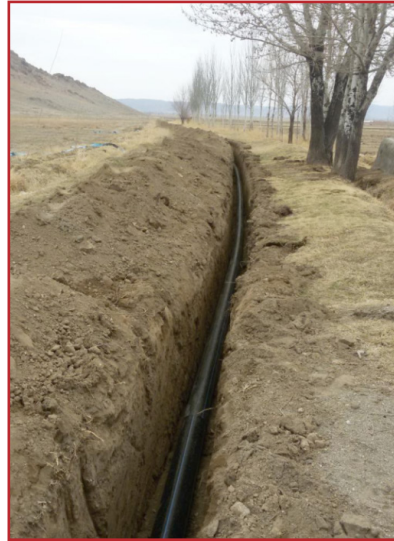
شکل ۴ - لوله گذاری (سمت چپ پروژه
