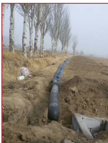
شکل ۱۲- اتصال لوله به خروجی از حوضچه (مزرعه عالی نژاد، شهرستان سلماس، روستای میناس)
