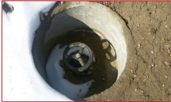
شکل ۷- شیرفلکه و غلاف دور آن (رعایت نکردن ارتفاع غلاف باعث شده رسوبات وارد اطراف شیر گردد)
