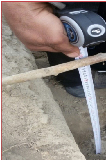
شکل ۶ - آماده کردن لوله های شبکه توزیع به همراه جوش اتصالات و همچنین کنترل عمق ترانشه قبل
