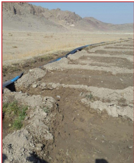
شکل ۱۶ - استقرار لی فلت در بالادست نوارهای آبیاری
