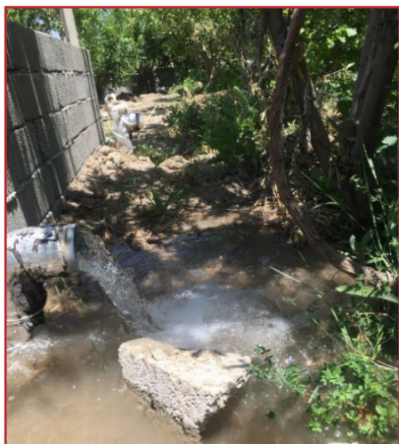
شکل ۱۸ - نمونه‌ای از پروژه کم‌فشار اجرا شده در باغات روستای کولق ارومیه (از نوع تخلیه به اتمسفر)
