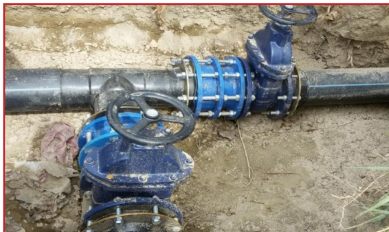
شکل ۹- اتصالات قابل پیاده شدن و مونتاژ حوضچه (مزرعه فایز، شهرستان سلماس، روستای صدیقیان)
