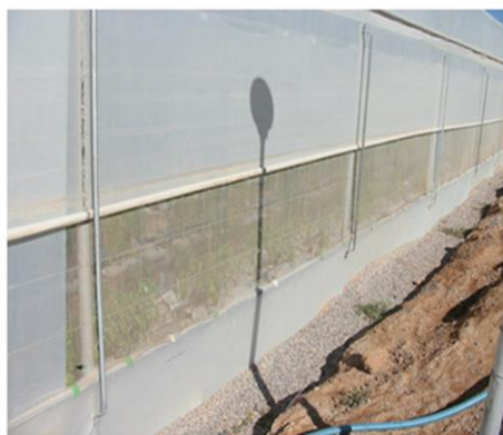
شکل ۴: نصب توری ضد حشره برای جلوگیری از ورود ناقلین به داخل گلخانه
