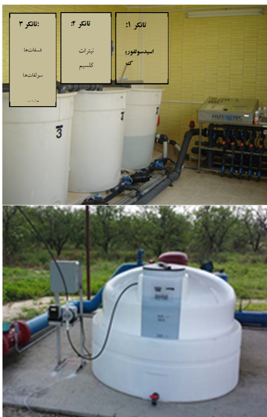
شکل ۳- تانکر ویژه تزریق اسیدسولفوریک در سیستم‌های آبیاری تحت فشار (راست)، نمونه‌ای دیگر از یک تانکر ویژه اسید در سیستم‌های آبیاری تحت فشار به همراه پمپ تزریق مخصوص اسید
