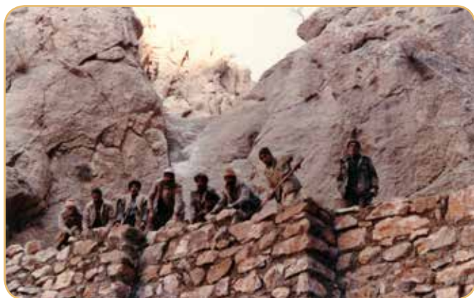
تصویر شماره ۲۸۹- ساخت راه با بالا بردن ارتفاع به شکل پلکانی سرخه دیزه - زمستان ۱۳۶۵
