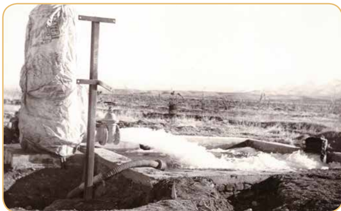
تصویر شماره ۱۷۶ - پمپاژ از چاه پمپاژ از چاه آب باغ میوه کوروش کبیر کرمانشاه - ۱۳۵۰
