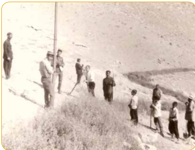
تصویر شماره ۱۶۸- لوله کشی آب آشامیدنی برای روستای قشلاق، منطقه خدابنده لو، صحنه، کرمانشاه - ۱۳۴۹- مردم کار حفر خط لوله را بین خودشان تقسیم کرده بودند و هر بخشی از خط لوله مشخص بود که سهم کدام خانواده هاست که برای کمک بیایند.
