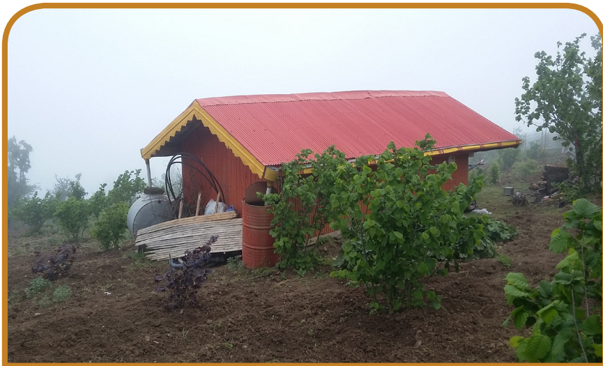
شکل ۱- استحصال آب باران از سقف شیروانی ساختمان در روستای کوهستانی سراورسو- اشکور رودسر
