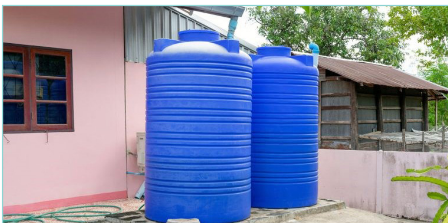
▲ شکل ۷- جمع‌آوری و ذخیره آب باران در مخازن برای زمین با مقیاس کم از جمله باغچه‌های کوچک
