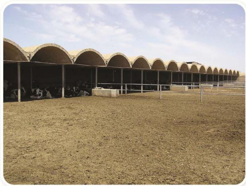
وضعیت مناسب نور و تهویه در یک جایگاه نیمه باز
