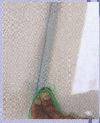
تصویر ۱۱ : طریقه صحیح صاف کردن سطح چسب
