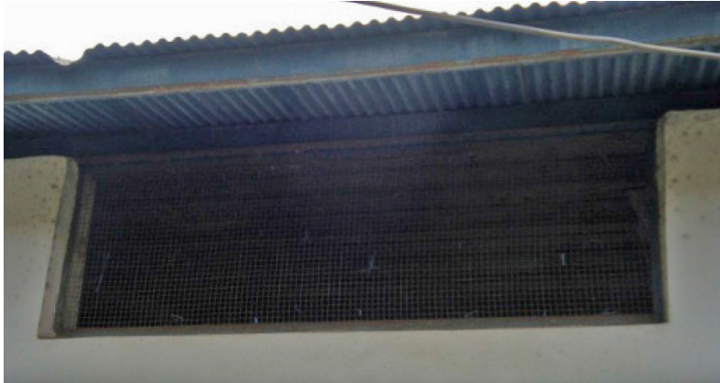
شکل ۲۷- توری نصب شده روی پنجره در بالاترین قسمت دیوار انبار
