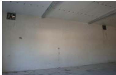
شکل ۱۰- عایق بندی سقف انبار
