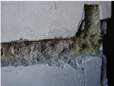
شکل ۹- استفاده از مواد عایق در ساخت دیوارهای انبار
