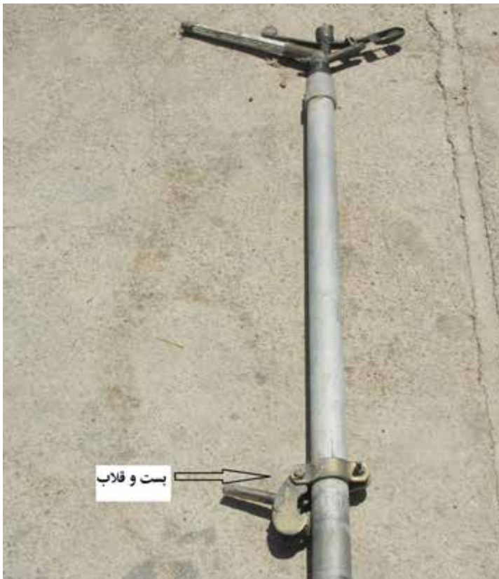
تصویر ۹ - بست و قلاب بسته شده روی رایزر که ممکن است از محل خود حرکت کند
