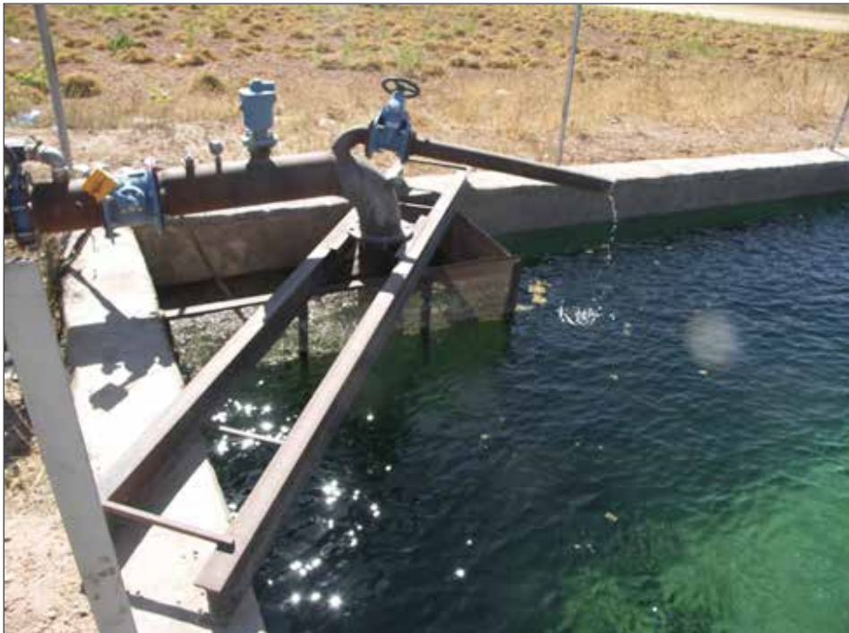
تصویر ۵ - استخر ذخیره آب و فیلتر موجود جهت پمپاژ آب در سامانه آبیاری بارانی
