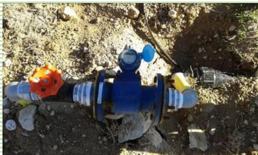
شکل ۵- کنتور نصب شده بر روی خط لوله
