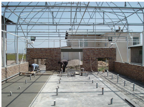
شکل ۱- کف بتونی و لوله کشی گلخانه
