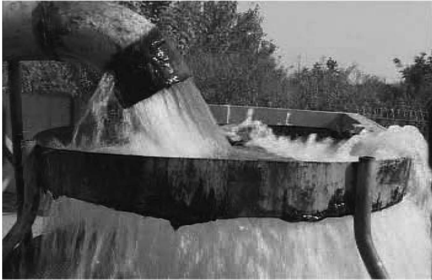
ریزش آب به اولین ردیف برج هوادهی به منظور تعادل گازی و افزایش اکسیژن محلول
