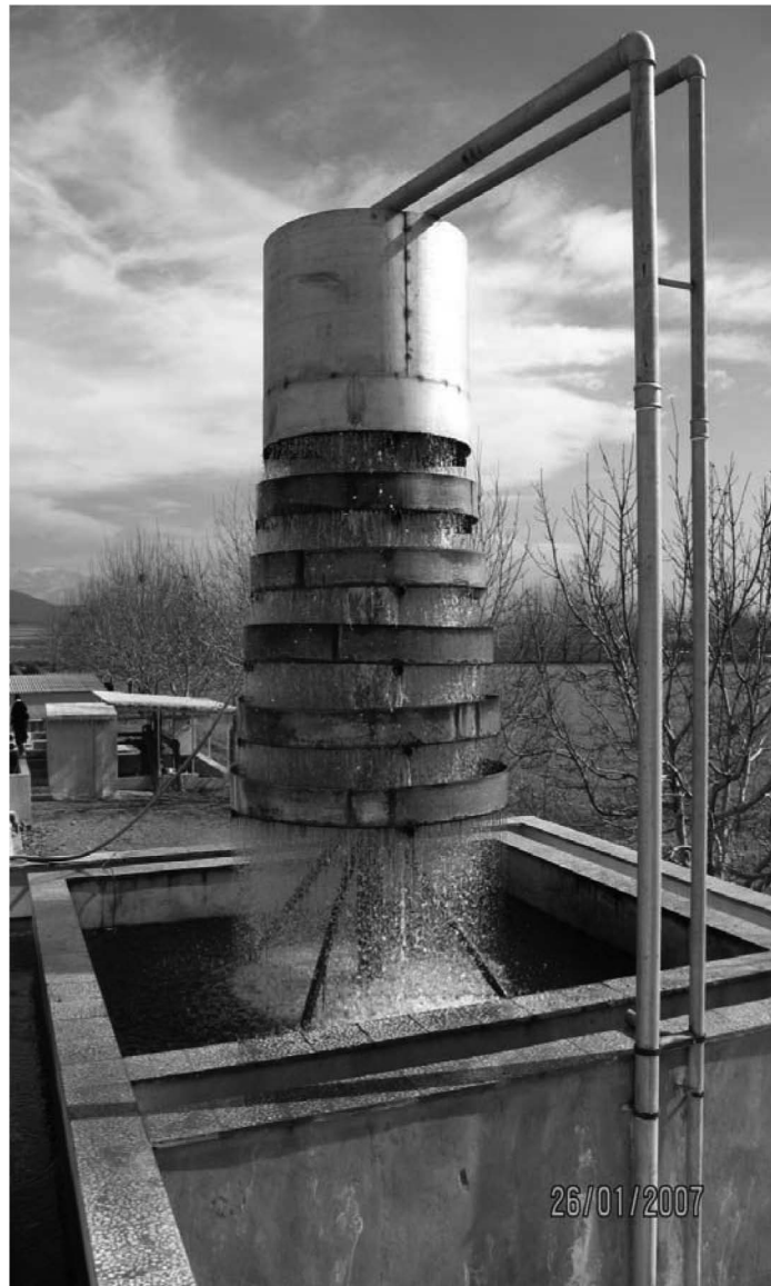
برج هوادهی برای رفع گازهای زائد و افزایش اکسیژن محلول آب برای پرورش ماهی قزل آلا
