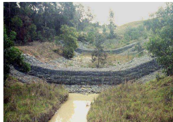
شکل ۵- ج و د) تندآب‌های با تاج و سطح منحنی وار
