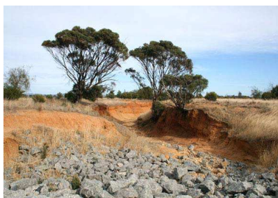
شکل ۱۹- ب) سرریز سنگی در محل خمیدگی کانال احداث شده
