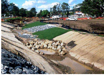
شکل ۴- سرریز سنگی با نیمرخ منحنی وار
