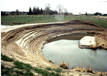
شکل ۵- ج و د) تندآب‌های با تاج و سطح منحنی وار
