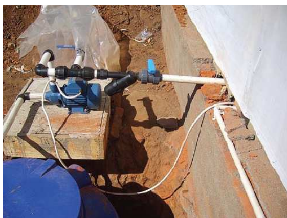
شکل ۲۴- نصب پمپ و مخزن بیرونی ( نقش شیر آبی تیره بالای پمپ بیرون، انتقال محلول غذایی از مخزن است. شیر معمولی کنار فیلتر سیاه باید بسته باشد)
