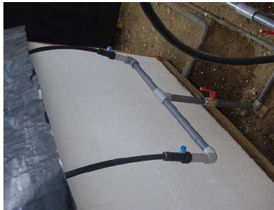
شکل ۲۷- نصب لوله تغذیه کننده برای جعبه های عریض (دوبل)
