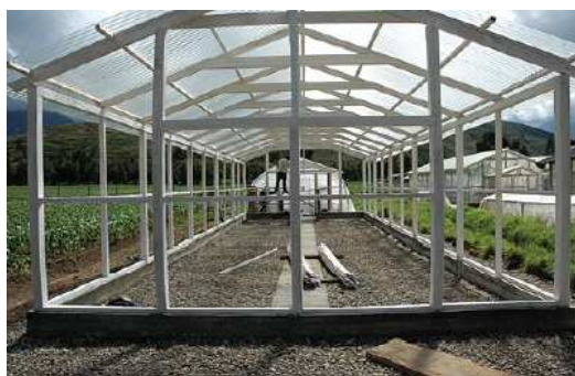
شکل ۸- پایه رویی گلخانه و سقف پلی کربنات (نمای پشت گلخانه)
