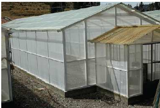
شکل ۹- گلخانه تکمیل شده با سقف پلاستیکی و یک ورودی
