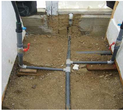
شکل ۲۶- نصب لوله تغذیه کننده با شیرهای مستقل
