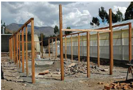
شکل ۷- توزیع ساختار چوبی یک گلخانه ۵×۱۵ متر و پایه سطح زمین (نمای جلویی)
