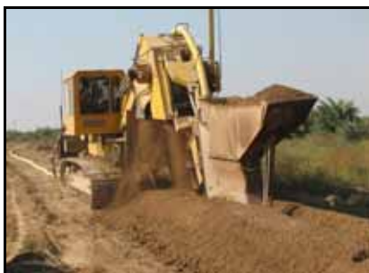
شکل ۳- پوشش معدنی در حال استفاده در یک پروژه زهکشی زیرزمینی در خوزستان شکل ۴ - نحوه لوله‌گذاری و کاربرد پوشش معدنی با استفاده از ترنچر
