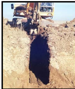
شکل ۳- حفر ترانشه زهکش زیرزمینی در مزرعه آزمایشی آونجان فارس
