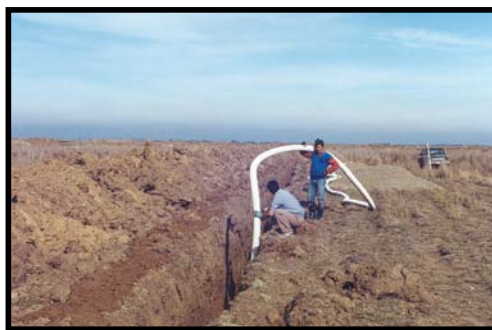
شکل ۲- عملیات لوله‌گذاری در مزرعه آزمایشی کشت و صنعت مغان
