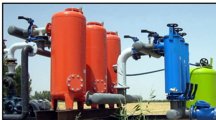
شکل ۳- ایستگاه کنترل مرکزی سیستم آبیاری قطره‌ای
