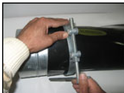
شکل ۶- نحوه به کار بردن رابط و بست فلزی
