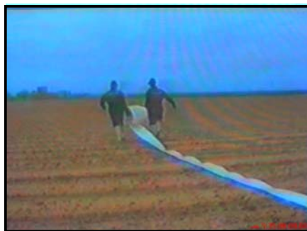
شکل ۱۳- نحوه پهن کردن لوله‌ها
