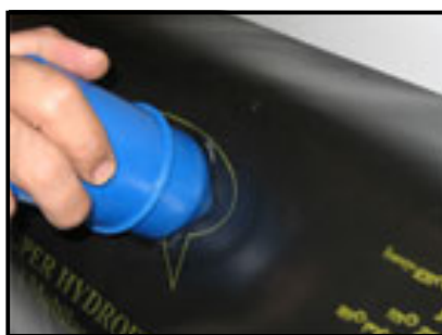
شکل ۱۰- نحوه نصب دریچه‌های پیچی
