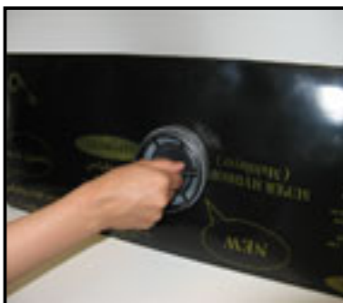
شکل ۹- نحوه باز و بستن دریچه‌ها
