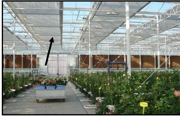
شکل ۴- پرده سایه انداز با مکانیزم رفت و برگشتی
