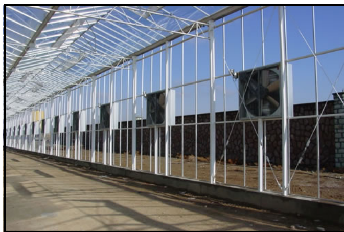
شکل ۱- پنکه‌های دیواری به منظور تهویه هوا
