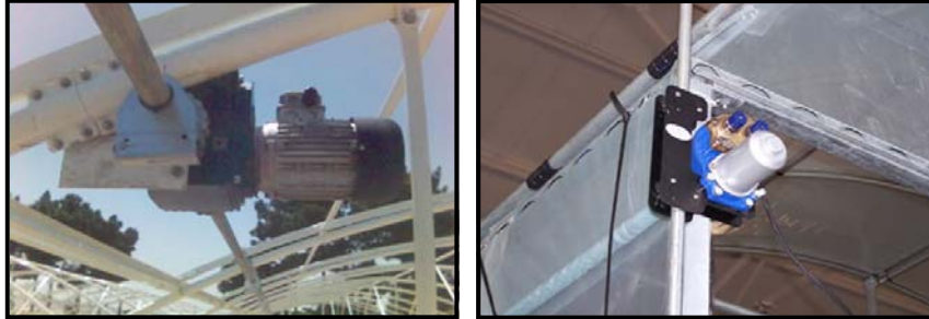
شکل ۲- ریل، چرخ دنده و موتور برای باز و بسته کردن پنجره‌های سقفی
