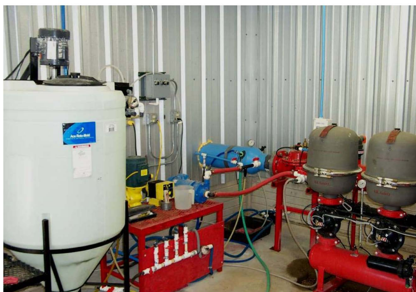
تصویر ۳- بخش تامین انرژی و تزریق مواد شیمیایی در سامانه زیرسطحی
