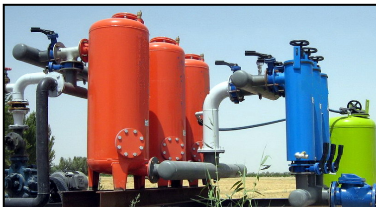
شکل ۳- ایستگاه کنترل مرکزی سیستم آبیاری قطره‌ای
