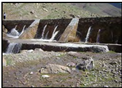
شکل ۱۳- سد سنگی ملاتی
