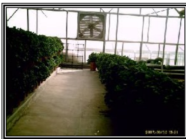
شکل ۵- استفاده از فن در سیستم خنک کننده و تهویه گلخانه
