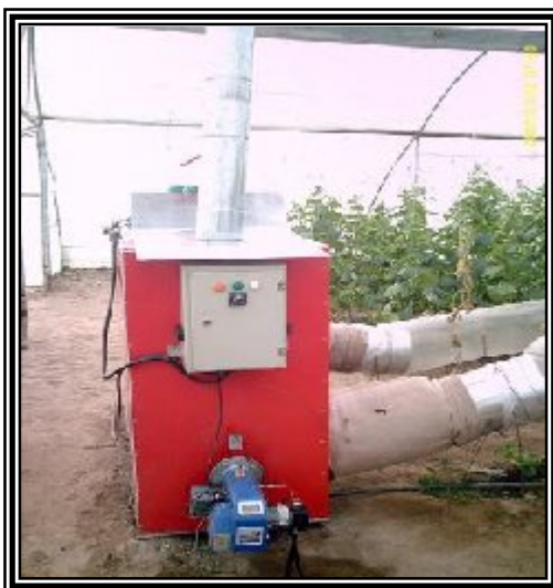
شکل ۲- استفاده از کوره هوای گرم در گلخانه
