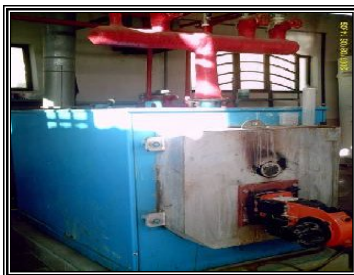
شکل ۱- استفاده از دیگ بخار در گلخانه.
