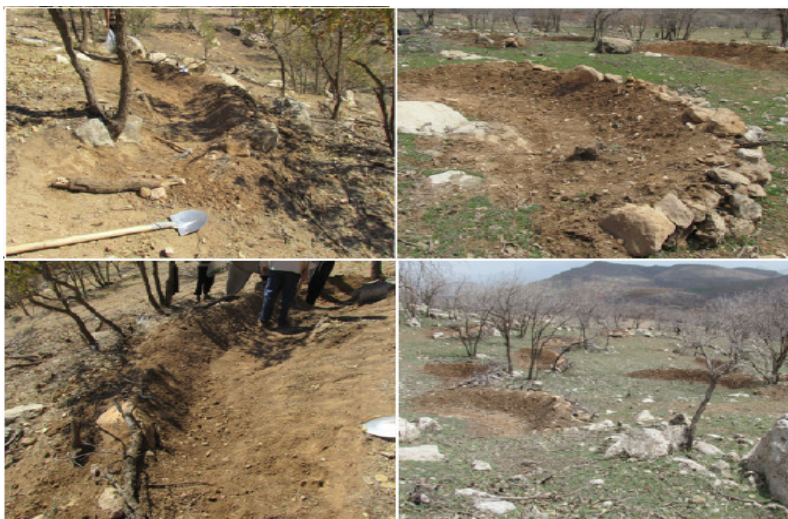
شکل ۵: احداث بانکت در منطقه مورد مطالعه. قبل از اجرا محل بانکت بر اساس بیشترین تاثیر و کمترین جابجایی خاک انتخاب گردید. از قطعات سنگ جدا شده و سرشاخه‌های خشک برای استحکام دیواره بانکت استفاده شد.
