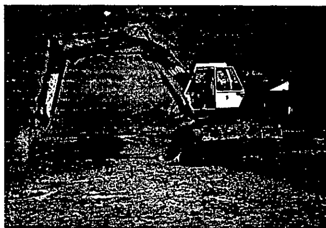
شکل ۴: احداث گوده‌های کاشت نخل با استفاده از بیل مکانیکی (Back hoe)
