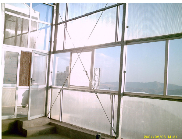
شکل-۳: پوشش های پلاستیکی دو جداره
