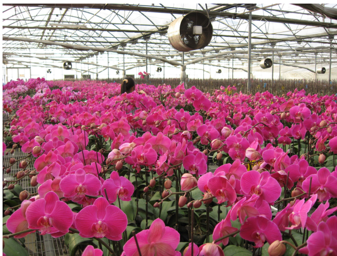
شکل-۲: استفاده از فن های مخصوص جابجا کننده هوا در گلخانه
