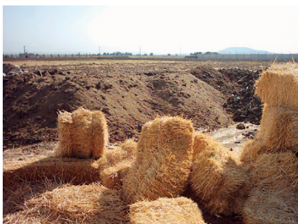
شکل شماره ۷-۱۵ - استفاده گاه و گلیش گندم و جو در کف کانال
