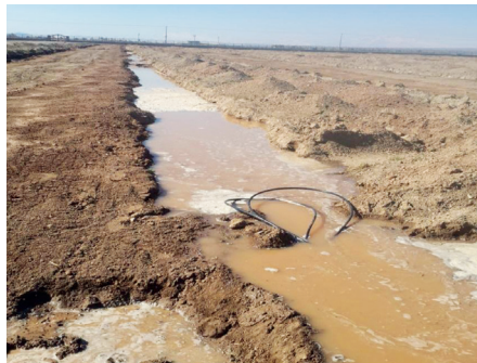
شکل شماره ۷-۲۲ - آبیاری شیارهای ایجاد شده بر روی کانال جهت نشست خاک کانال
