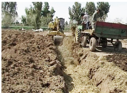
شکل شماره ۱۶-۷ - ریختن ضایعات گیاهی در کف کانال
