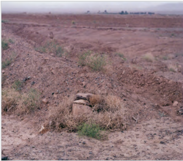
شکل ۱۶- سرریز انتهایی بندسار
