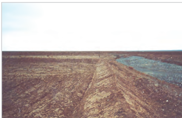
شکل ۱- بندسارهای ساخته‌شده روی مخروط افکنه دو سمت خشکه‌رود
