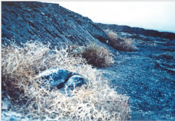
شکل ۱۹- برای جلوگیری از شسته شدن دیواره بندسارهای واقع در مجاورت رودخانه از ساختمان ساده‌ای موسوم به کله متشکل از بوته‌های خشک و سنگ استفاده می‌شود.
