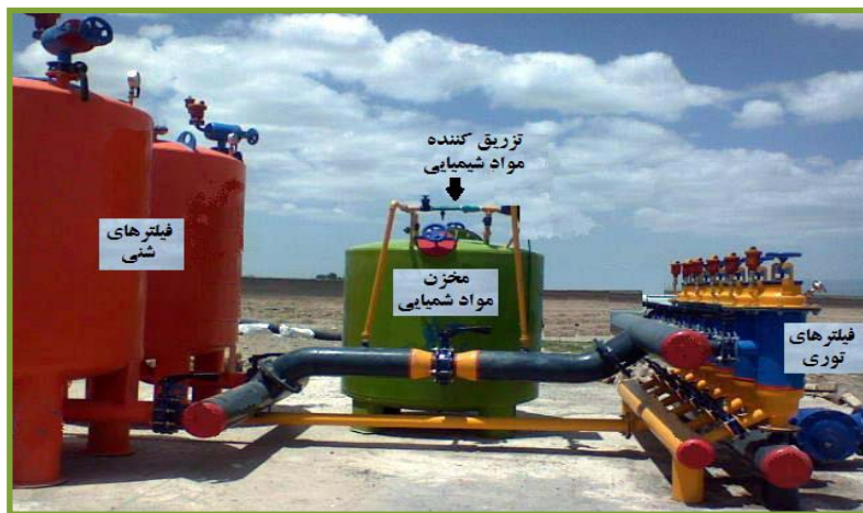
شکل ۸. نمای سیستم کنترل مرکزی کود آبیاری
