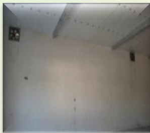
شکل ۱۰- عایق بندی سقف انبار
