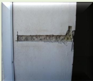
شکل ۹- استفاده از مواد عایق در ساخت دیوارهای انبار
