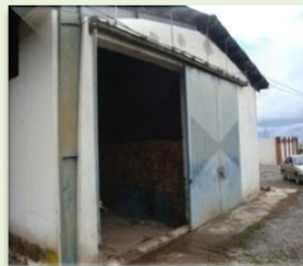
شکل ۲۵- ارتفاع پایین درب و باز شدن به بیرون
