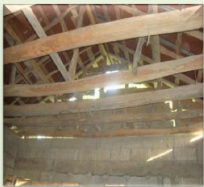
شکل ۱۱- سقف نامناسب و بدون عایق بندی
