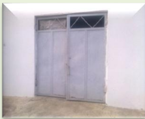
شکل ۲۶- درب‌های جانبی برای انبارهای با اندازه متوسط و بزرگ
