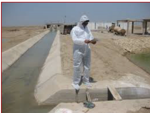
شکل ۱۰- ورود آب تمیز از استخر ذخیره
