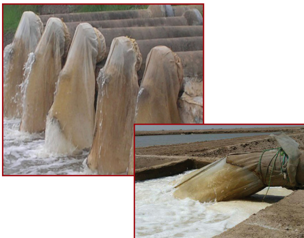
شکل ۱۱- تصفیه آب به کمک فیلترهای کیسه‌ای
