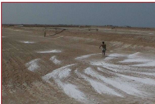
شکل ۹- نحوه پخش آهک در کف استخر
