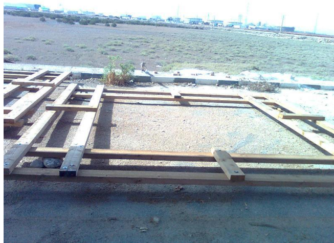
شکل ۱- چارچوب تخته‌ای رویی قفس‌های ساخته شده به ابعاد ۳*۳ متر در ایستگاه تحقیقاتی ماهیان دریایی بندر امام خمینی (ره) (عکس از مؤلفین)
