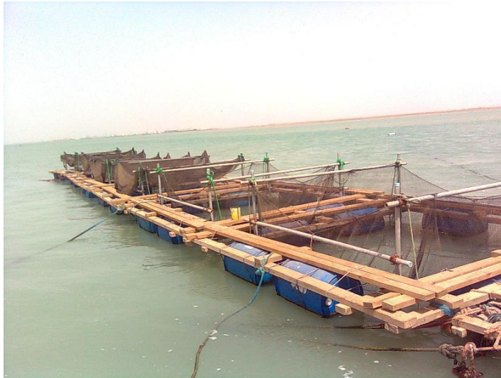
شکل ۵- قفس های ساخته شده در ایستگاه تحقیقاتی ماهیان دریایی بندر امام خمینی (ره) در محل استقرار قفس ها در خور غزاله، تخته های روی بشکه ها جهت تردد بین قفسها و دسترسی به آنها استفاده می شود (عکس از مؤلفین)
