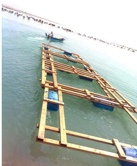
شکل ۳- قرار دادن بشکه های ۲۰۰ لیتری در قفسهای ساخته شده در ایستگاه تحقیقاتی ماهیان دریایی بندر امام خمینی (ره) (عکس از مؤلفین)
