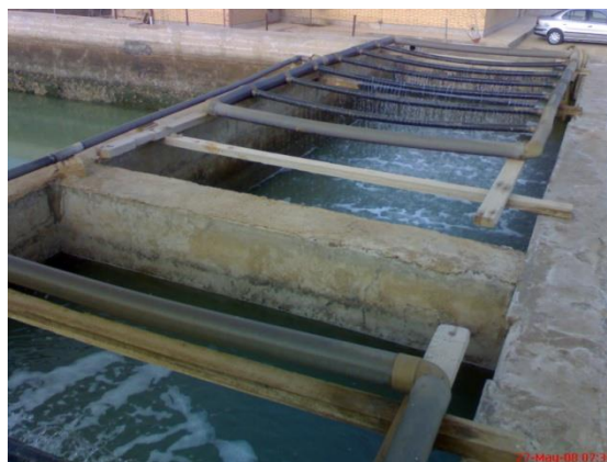
شکل ۴: فیلتر کردن آب دریا به کمک فیلتر شنی (آب به صورت بارانی روی فیلتر پاشیده می شود) (سمت راست) و تانکهای کلرزی ۷۰ تنی داخل سالی (سمت چپ) (عکس در ایستگاه تحقیقاتی ماهیان دریایی بندر امام خمینی (ره))
