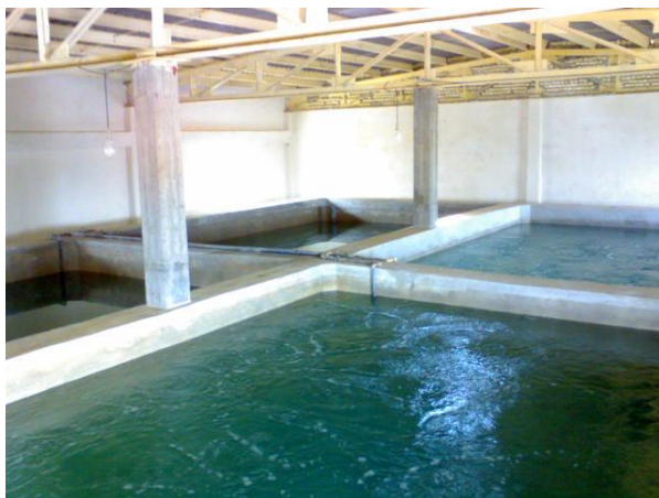
شکل ۴: فیلتر کردن آب دریا به کمک فیلتر شنی (آب به صورت بارانی روی فیلتر پاشیده می شود) (سمت راست) و تانکهای کلرزی ۷۰ تنی داخل سالی (سمت چپ) (عکس در ایستگاه تحقیقاتی ماهیان دریایی بندر امام خمینی (ره))
