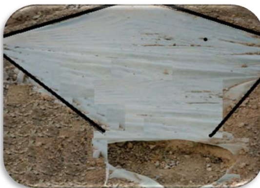
شکل ۴-۱۳ سامانه لوزی شکل با سطح عایق نایلونی، در اراضی شیب‌دار دشت آبدالان گچساران
