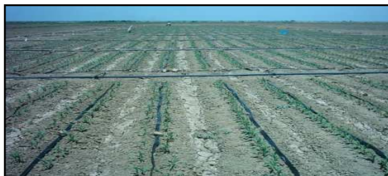
شکل ۱۶- پهن کردن لوله‌های تیپ
