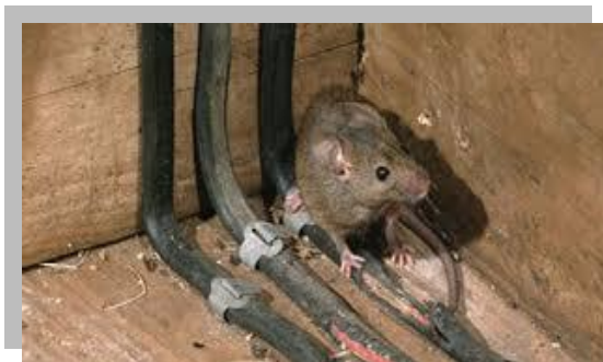
شکل 18- موش قهوه ای در حال جویدین پوسته روی کابل برق
