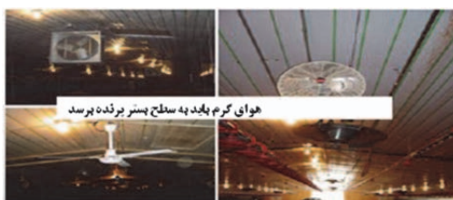
شکل ۲-۸- نحوه قرار گرفتن فن‌ها یا پنکه‌های جریان دهنده هوا را در سالن‌های پرورش
