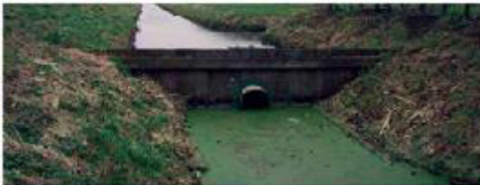
شکل ۴- سازه کنترل زهکشی در کانال جمع کننده
