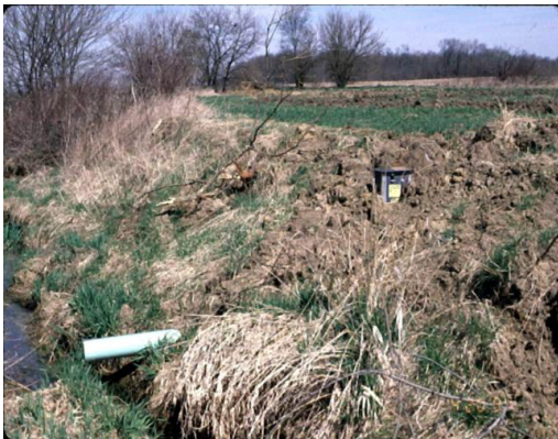
شکل ۸ - سازه کنترل نصب شده در مزرعه دارای زهکش
