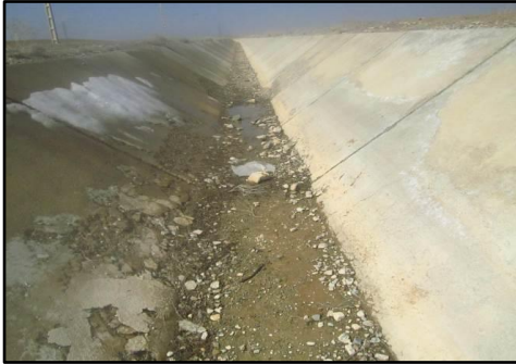
شکل ۱: تخریب پوشش بتنی در منطقه سردسیر
