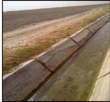
شکل ۱: تخریب پوشش بتنی در منطقه سردسیر
