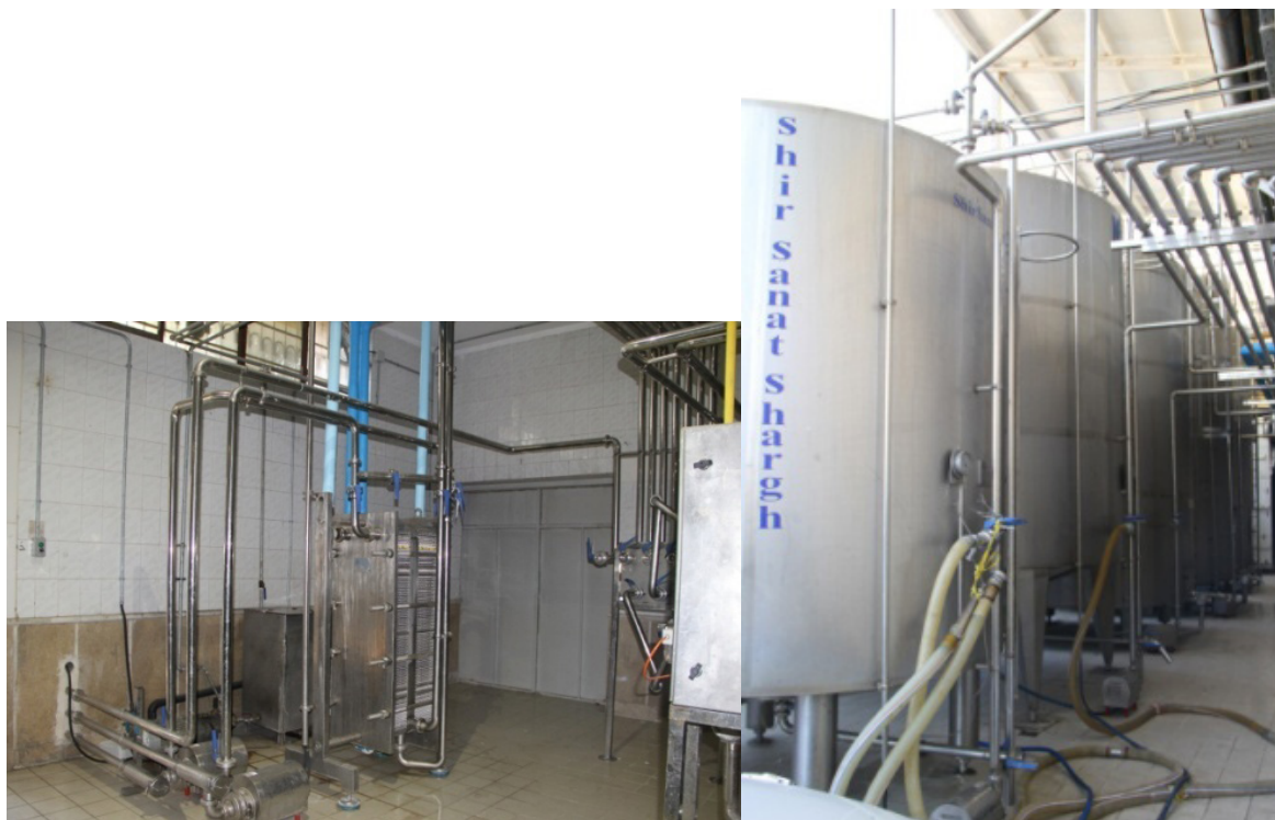
شکل ۹- مبدل حرارتی صفحه‌ای (بالا) برای سردکردن شیر و تانک استیل دوجداره جهت نگهداری شیر خام (پایین)
