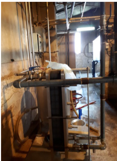
شکل ۶- سردکن صفحه‌ای (چپ) و مخزن آب سرد (راست) در محل دامداری برای سرد کردن شیر خام
