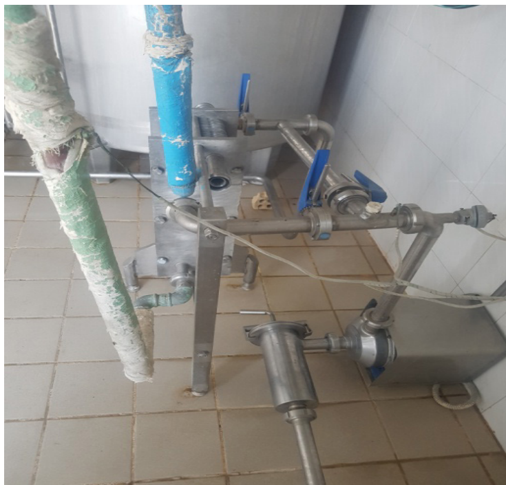
شکل ۱۱- صافی استیل شیر خام قبل از ورود به پمپ سانتریفوژی
